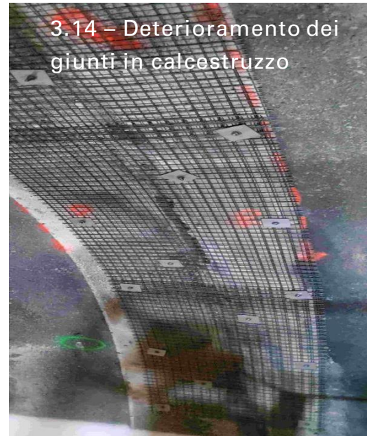
1.20 Deterioramento del calcestruzzo proiettato
