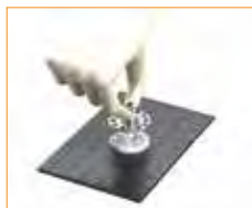
Posizionare Master-Plate® sul collante.
