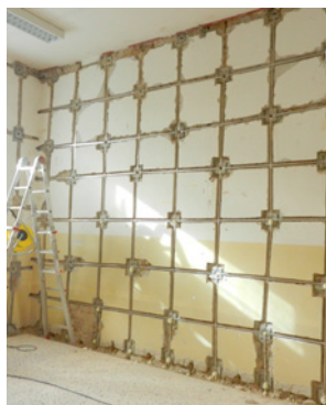
Reticolo applicato in traccia presso il Liceo Fascitelli (IS)
