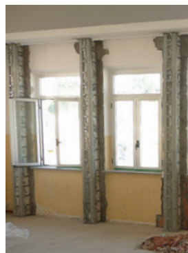
Scuola Nemesio Ricci a Corropoli: confinamento in forza di un pilastro in c.a. applicato senza smontare l'infisso
