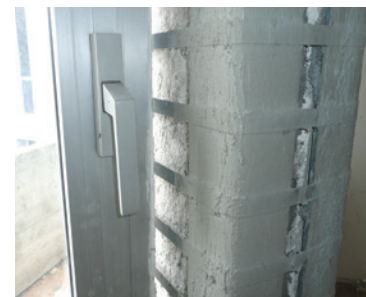
Scuola Nemesio Ricci a Corropoli: confinamento in forza di un pilastro in c.a. applicato senza smontare l'infisso
