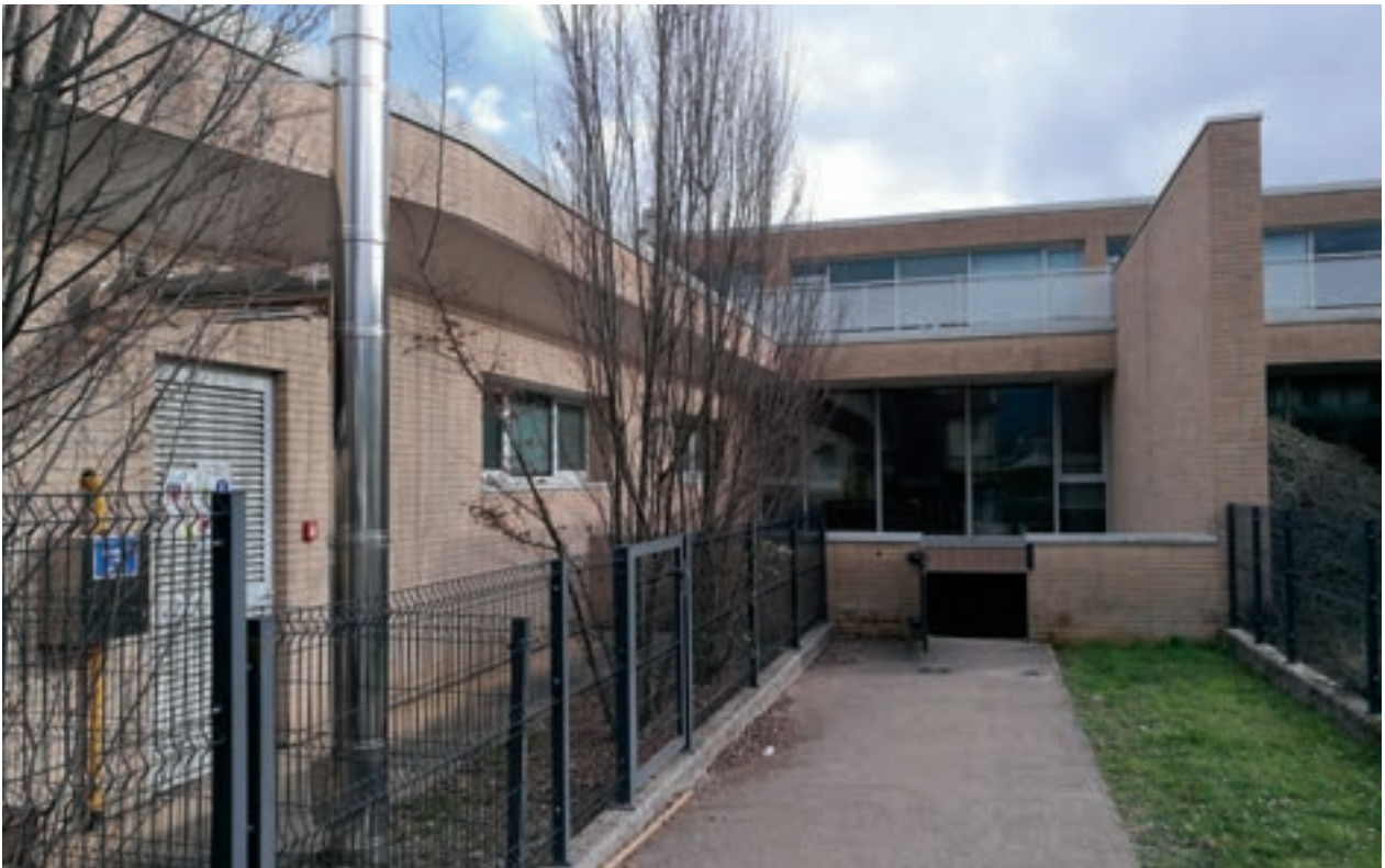
VISTA CORTILE INTERNO
