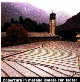
Copertura in metallo isolata con Isotec
