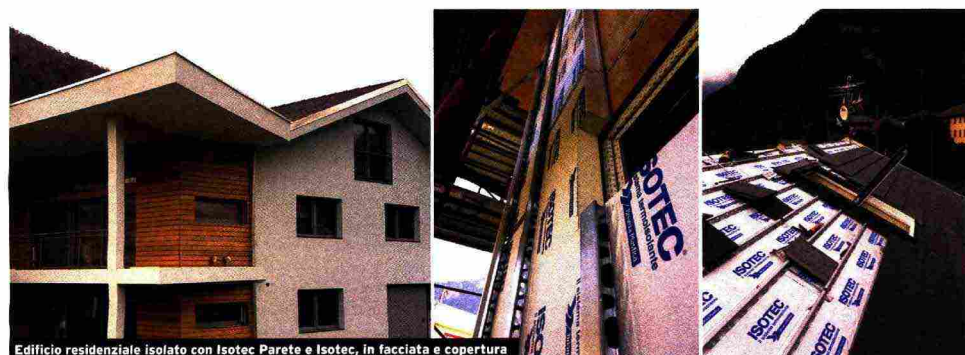
Edificio residenziale isolato con Isotec Parete e Isotec, in facciata e copertura
