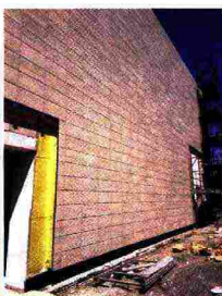
Copertura in metallo isolata con Isotec
