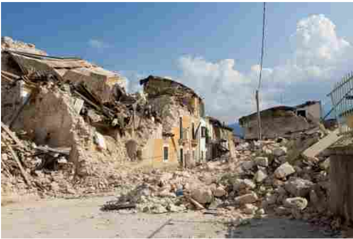
Terremoto, tra dolore e necessità di messa in sicurezza
