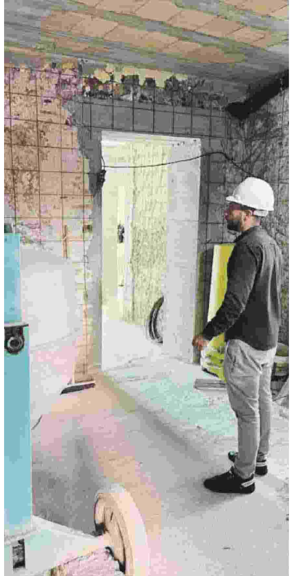
LAVORI Un cantiere del Sismabonus
