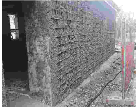
CANTIERE Lavori per il Sismabonus
