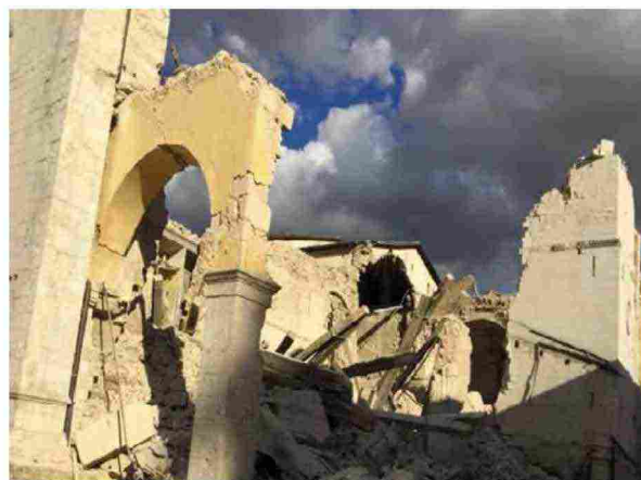
Basilica di San Benedetto dopo il terremoto
