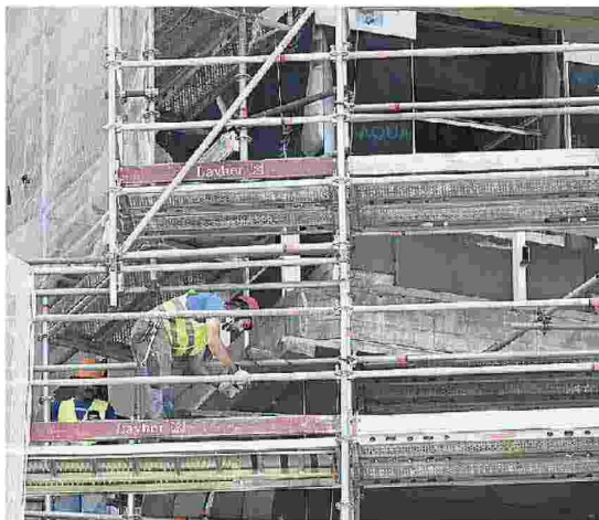
Un palazzo in ristrutturazione con gli incentivi del Superbonus
