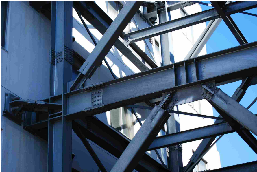
(Rinforzi strutturali con funzione antisismica realizzati all'esterno di un edificio pubblico. Foto Adobe Stock)
