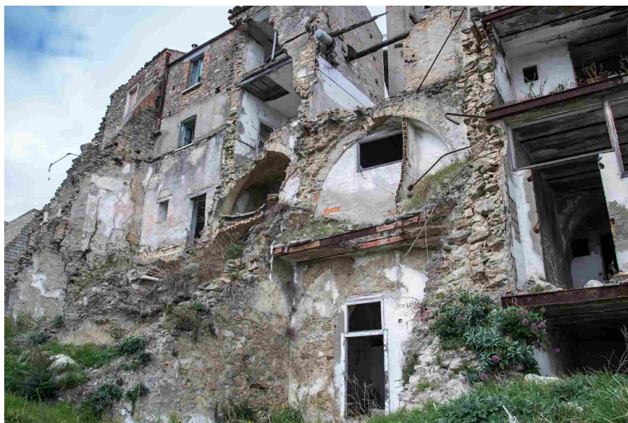
(L'abitato di Calitri - Avellino dopo il terremoto del 1980. Foto Adobe Stock)
