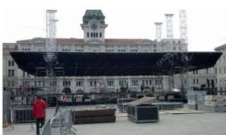
Figura 22 - Esempio di Ground support
