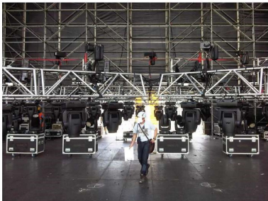
Figura 8 - Allestimento scenotecnico superiore realizzato sul palcoscenico e successivamente portato in quota mediante sistemi di sollevamento motorizzati (paranchi)
