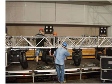
Figura 24 - Montaggio di proiettori operando a terra o a quota del palcoscenico
