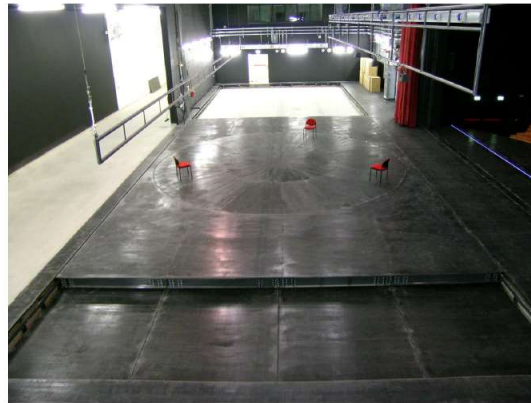
Figura 15 – Esempio di piattaforma a spostamento orizzontale e di piattaforma girevole
