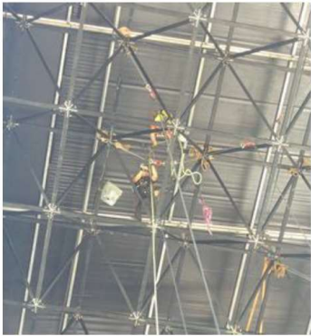
Figura 7 - Realizzazione del sistema di sospensione da parte dei Rigger
