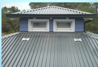
Esempi di dispositivi tipo A – UNI 11578
