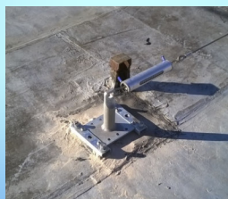
Esempi di dispositivi tipo C – UNI 11578
