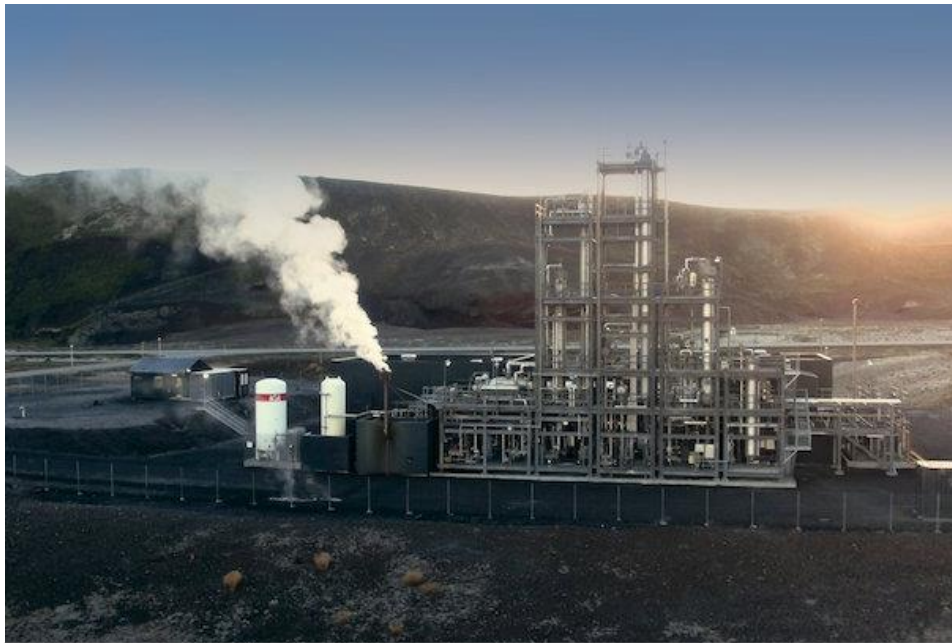
Impianto in Islanda
