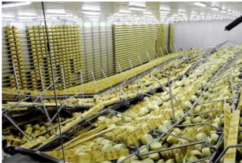
Le scalere, scaffali per la stagionatura delle forme di parmigiano, crollate nel terremoto del maggio 2012
