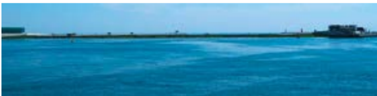
Fig. 6 - MoSE: la barriera di Malamocco chiusa (ore 12:30 del 10 luglio 2020)
