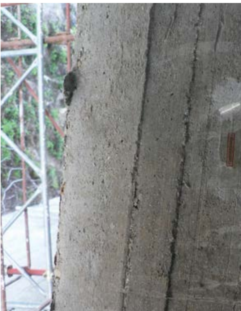
Figura 5. Estensimetro da 50 mm utilizzato per rilevazioni dinamiche su cemento armato precompresso
