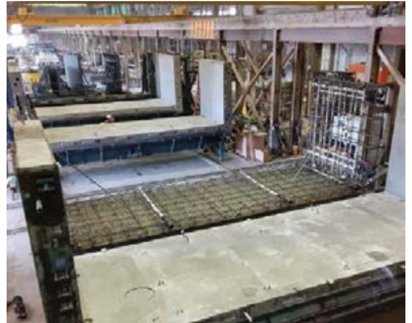
Figura 8. Pista di prefabbricazione
