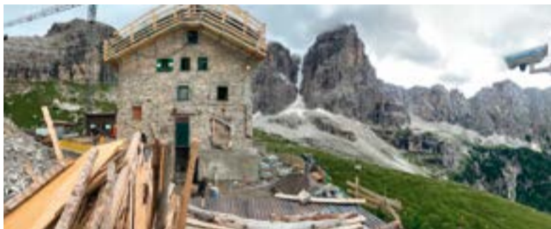
Dispositivo per un cantiere in montagna (fonte Timelapselab.it)
