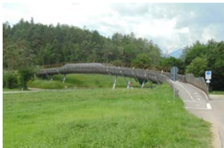
Figura 5. Il ponte ciclopedonale di Romeno (TN) "ramo de pomar" ("ramo di melo").
