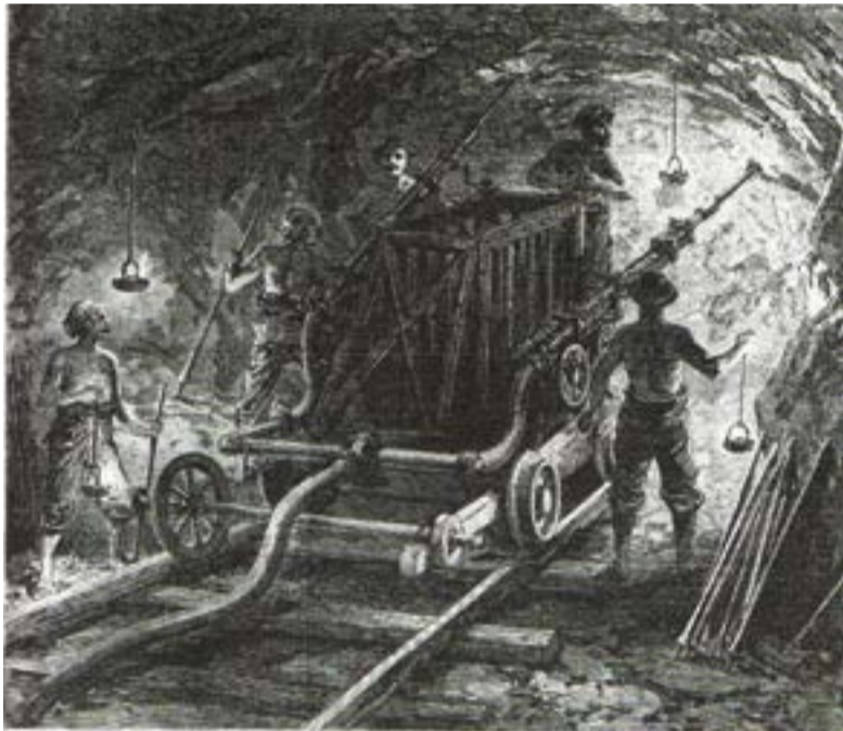
Illustrazione tratta da L'Univers illustré, Parigi, 1869, in cui è riprodotta la macchina perforatrice inventata da Germano Sommeiller per la perforazione del Tunnel del Frejus
