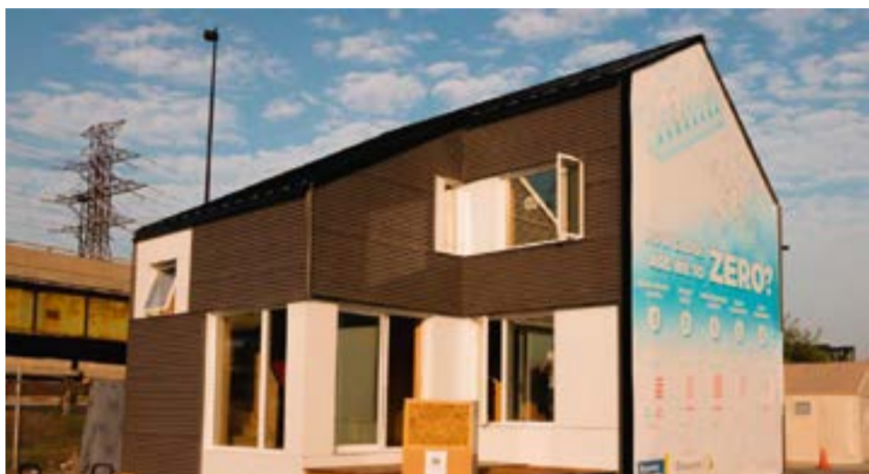
Foto del primo prototipo di una zero carbon-energy-water house progettata dal prof. Berardi a Toronto.
