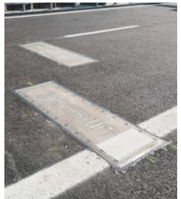
Sistema iWIM Bisonte annegato su ciascuna corsia della carreggiata est per l'individuazione dei veicoli in transito con un carico superiore al consentito (immagine fornita da CETENA).
