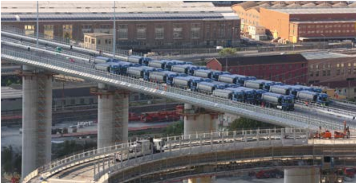
Veduta del ponte con i 54 tir da 44 tonnellate che hanno effettuato tra il 19 e 22 luglio il collaudo statico e dinamico del ponte (immagine fornita da PerGenova).
