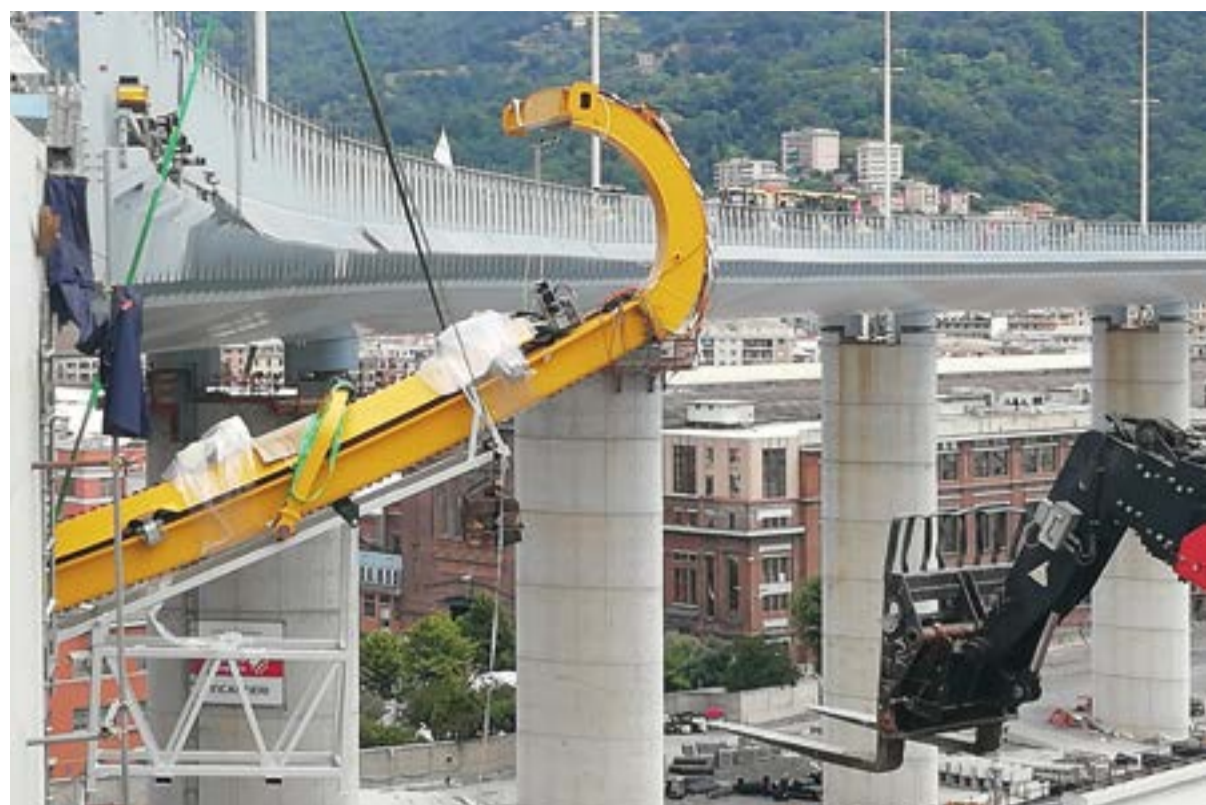
Posizionamento del braccio meccanico del robot-inspection (immagine fornita da IIT - Camozzi).
