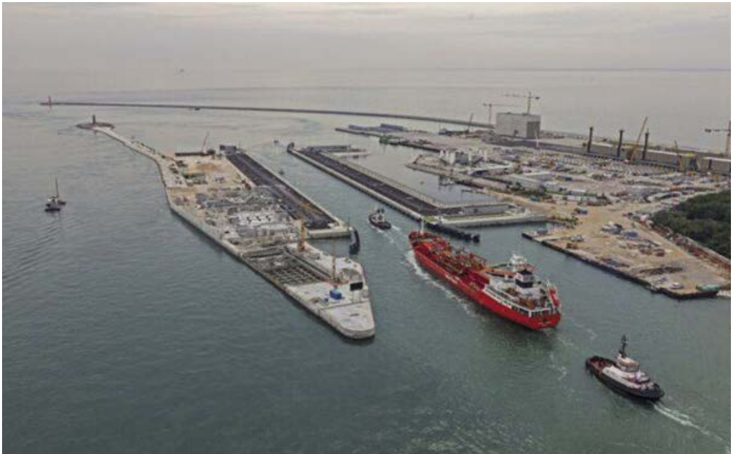
Figura 10. Malamocco: la conca di navigazione in servizio (agosto 2014) (Fonte: Consorzio Venezia Nuova)
