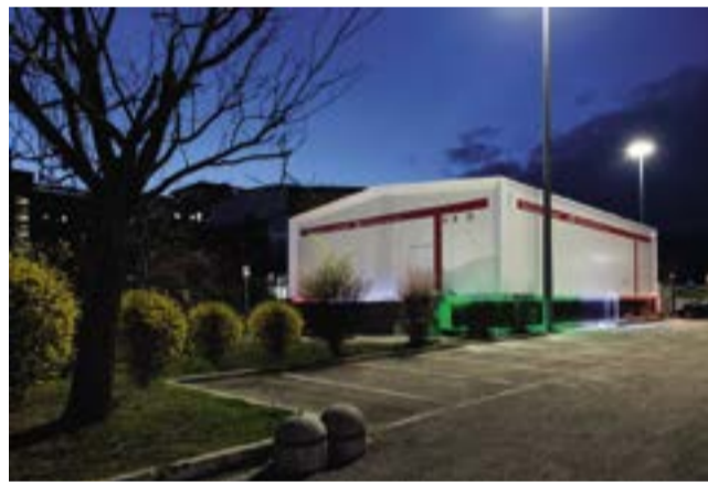
Conclusione dei lavori
