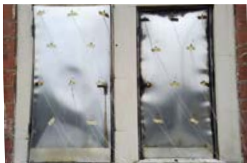
Foto 6. Test fuoco rei antisismica - 134 min
