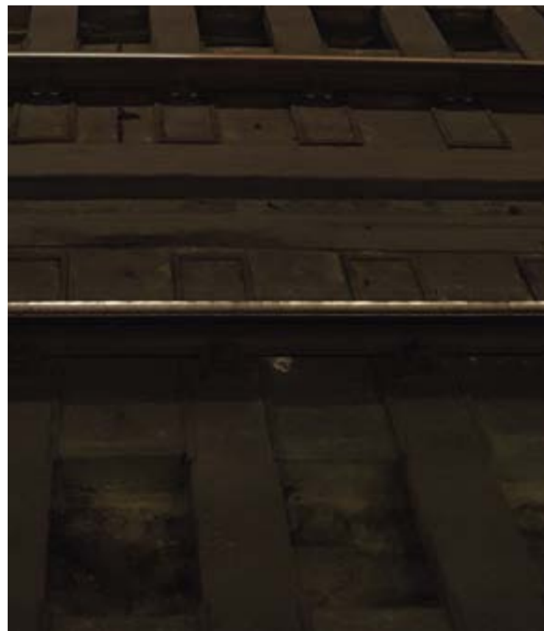
Figura 5. Sulle rotaie della stazione Moscova della linea M2 di Milano si vedono i tratti con diversa luminosità della luce riflessa dalle lampade della banchina opposta. La diversa riflessione è dovuta alla mazzatura e si possono contare all'incirca 10 avvallamenti (con maggiore riflessione della luce) di mazzatura su un tratto di rotaia di circa 70 cm tra due traversine. Quindi la lunghezza d'onda della mazzatura è di circa 7 cm
