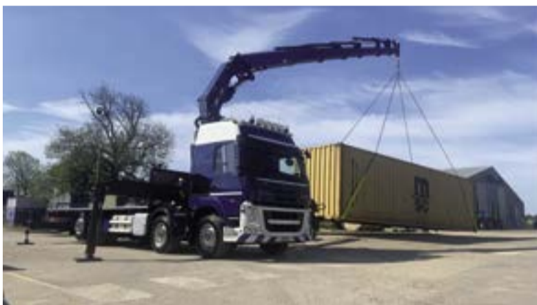
Figura 2. Gru a bracci articolati nella fase di sollevamento (fonte HCE srl)
