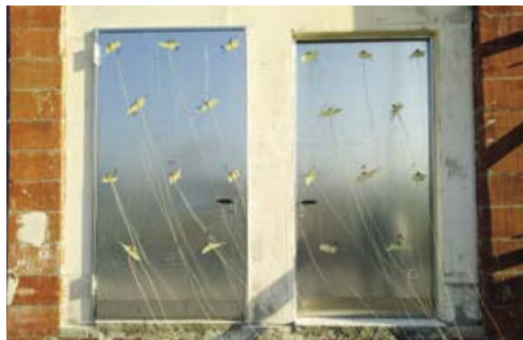
Foto 5. Test fuoco rei antisismica
