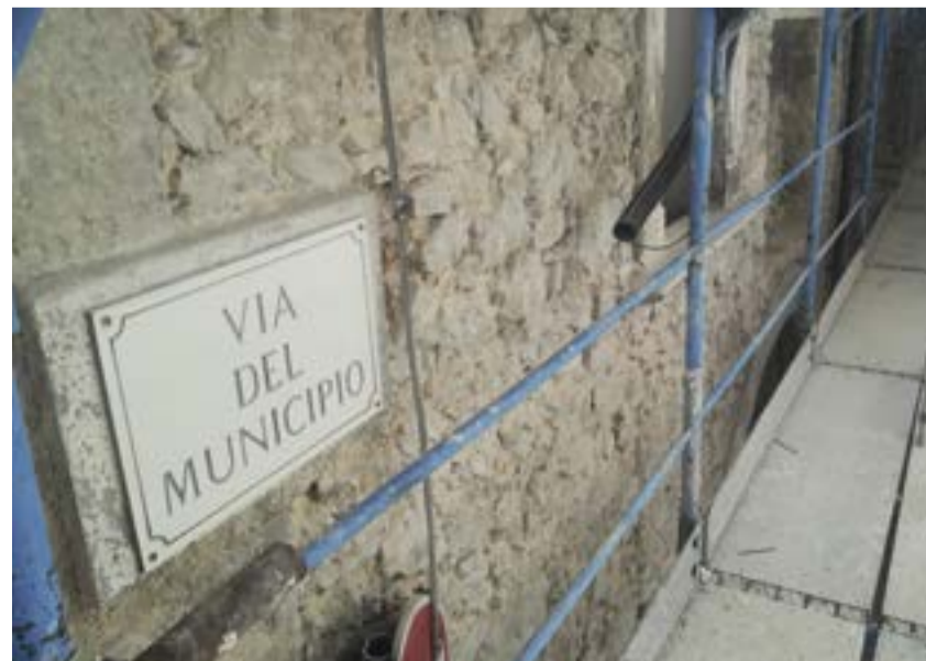
Messa a nudo della muratura portante
