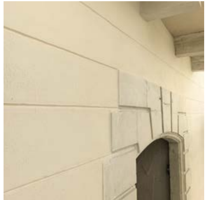
Fasce d'intonaco e imbotti in pietra
