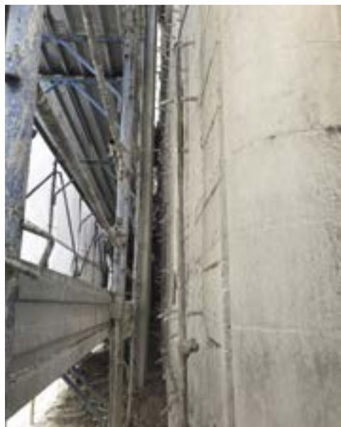
Interventi strutturali sulla muratura con iniezioni
