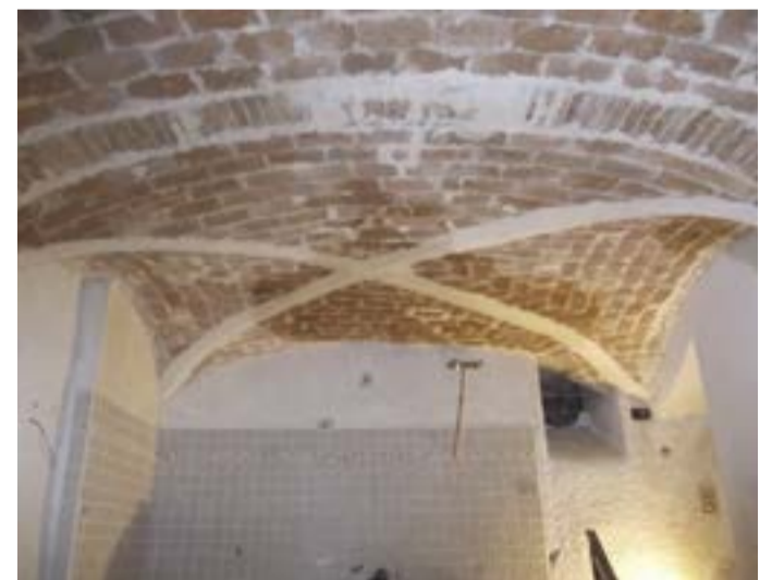
Consolidamento delle volte in pietra o in laterizio con reti e connettori abbinati a malta e realizzazione di una cappa collaborante a basso spessore
