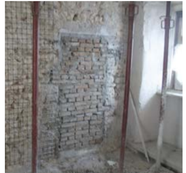
Chiusura delle nicchie con mattoni pieni in laterizio
