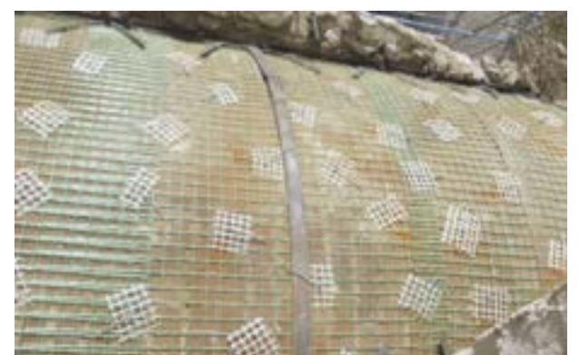
Consolidamento delle volte in pietra o in laterizio con reti e connettori abbinati a malta e realizzazione di una cappa collaborante a basso spessore
