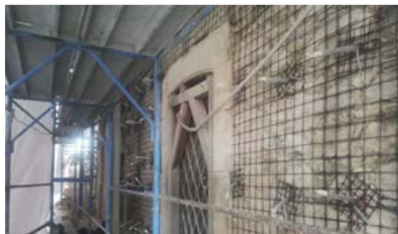
Rinforzo delle murature mediante applicazione di rete in fibra di vetro (G.F.R.P.) e iniezioni di miscela di leganti
