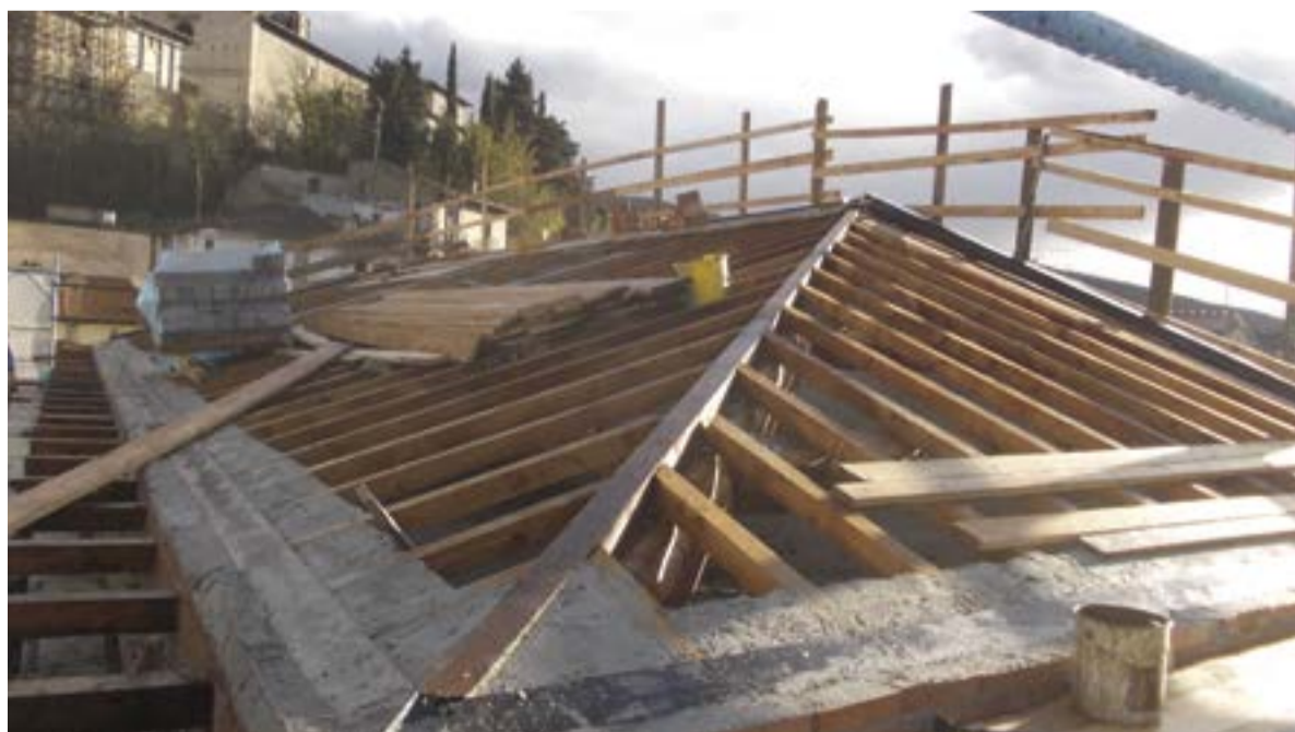
Nuove coperture in legno
