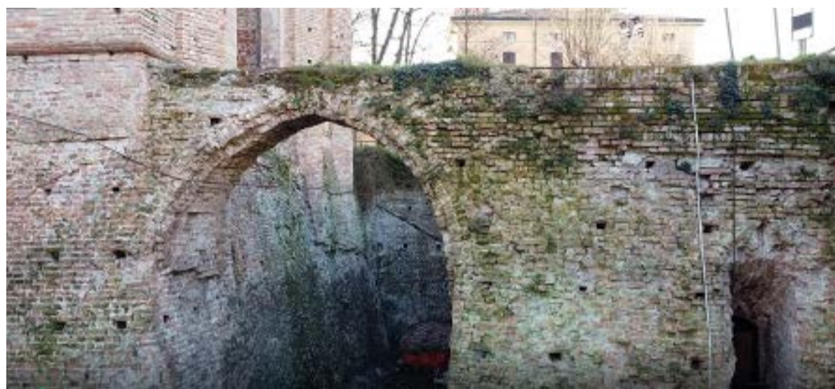
Foto 4. Strutture del ponte levatoio e porta del soccorso
