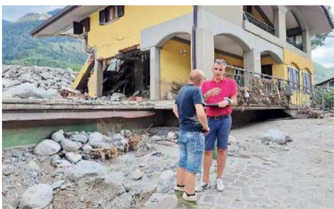
L'ing. Minelli durante uno dei tre giorni di perizie a Niardo
