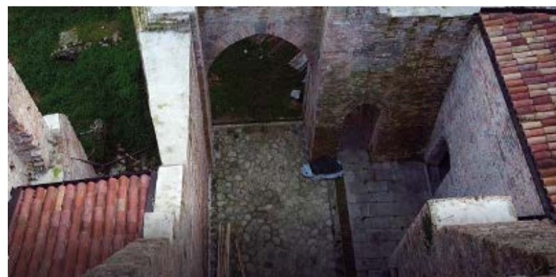
Foto 5. Il rivellino esterno: vista con drone
