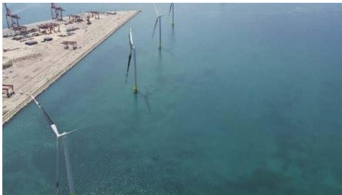
Ripresa aerea del parco eolico
