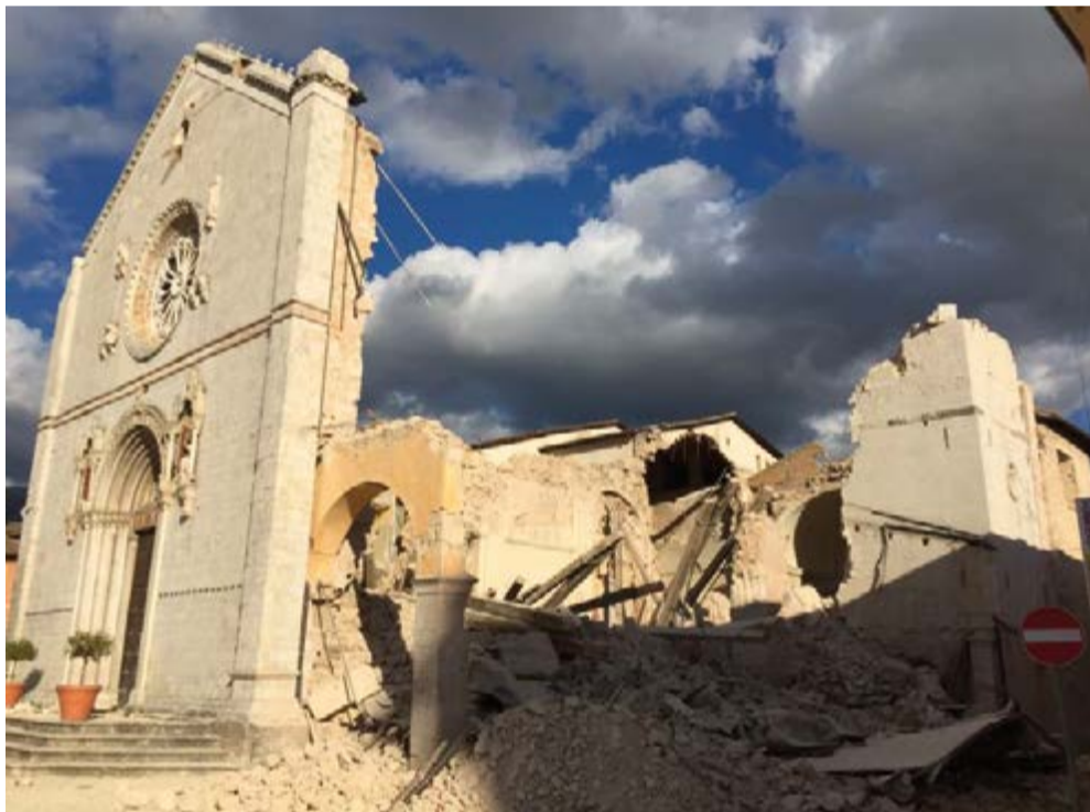
Basilica di San Benedetto dopo il terremoto
